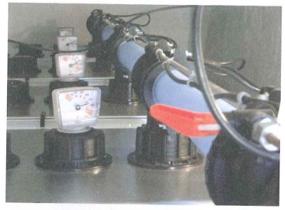
■ Dehoust-Sicherheitstanks und das Sicherheitszubehör DE-A-01 machen bauseitige Auffangräume überflüssig und verhindern ein Überfüllen der Tankanlage, auch bei schwer zugänglichen Lagerräumen.
