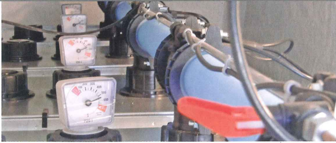
Sicherheitstanks und Füllsicherung von Dehoust machen bauseitige Auffangräume überflüssig und verhindern ein Überfüllen der Tankanlage, auch bei schwer zugänglichen Lagerräumen.
