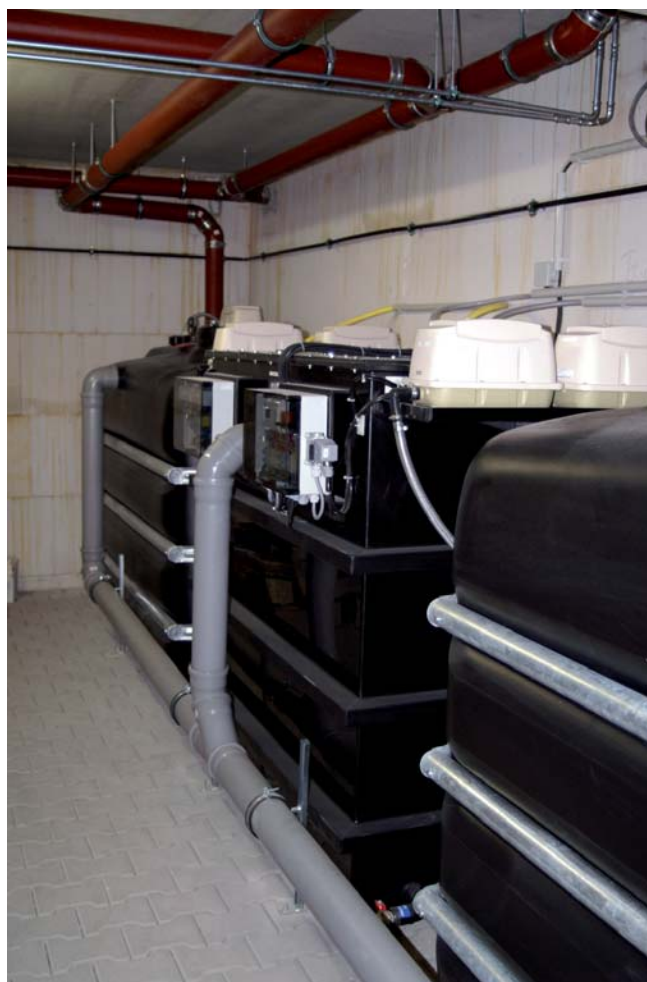
GEP-Grauwasseranlage Typ 4
